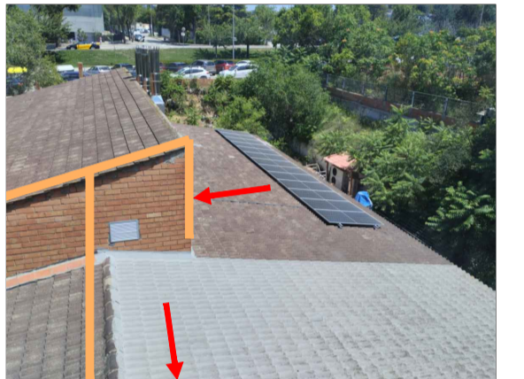
ENTRADA CABLEJAT CC A L'INTERIOR DE L'EDIFICI PER FAÇANA
